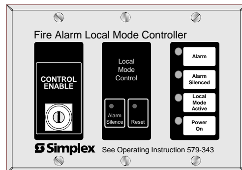
Local Mode Controller Module
